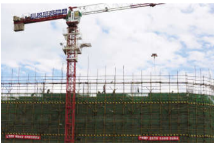
建筑工人们正在加紧施工建设
