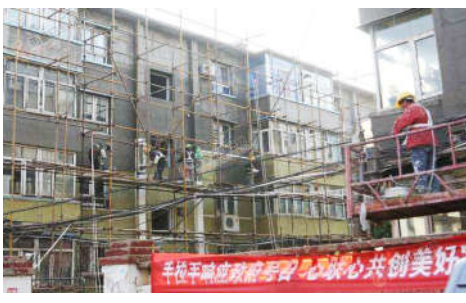
老旧小区改造现场，工人们正在对老旧房屋进行加固和改造。
