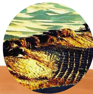
1997年我国第一条穿沙公路的修建场景
