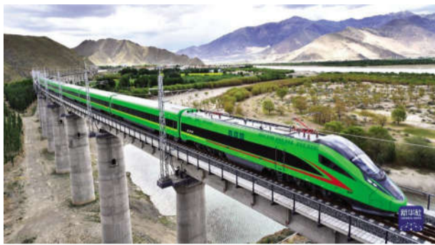
6月25日，全长435公里、设计时速160公里的拉林铁路建成通车，西藏首条电气化铁路建成，同时复兴号实现对31个自治区全覆盖。这是试运行的复兴号列车行驶在西藏山南市境内（6月16日摄）。（摄影 党果）
