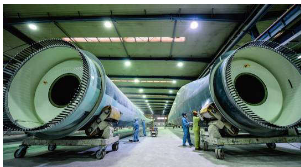
3月17日,内蒙古鄂尔多斯装备制造工业园区内,一家新材料科技股份有限公司蒙西分公司的工人正在进行风叶壳外部补强作业 彭源 摄
