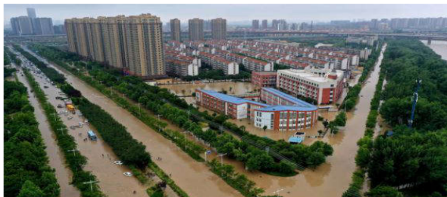
7月21日,无人机拍摄的被积水淹没的郑州市郑东新区金水东路
