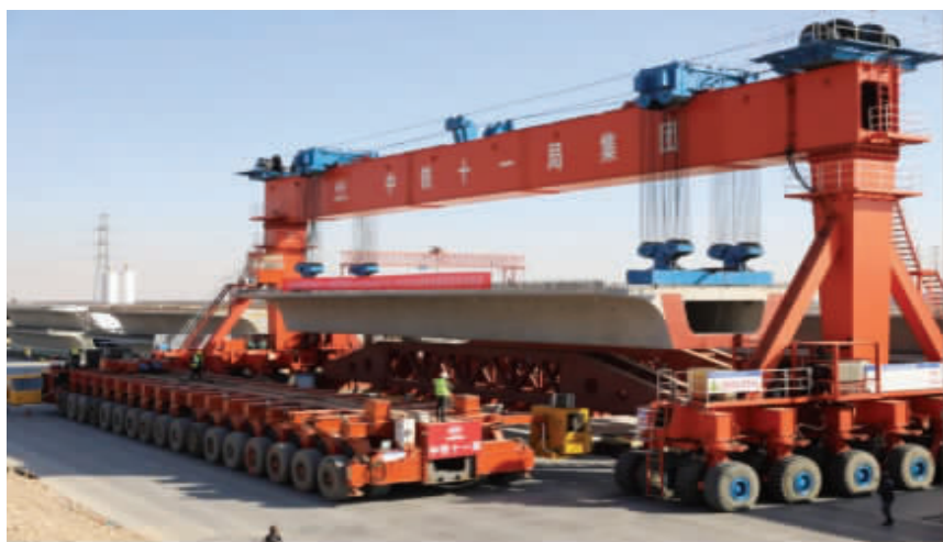
包银铁路包头至临河段首榀箱梁成功架设
