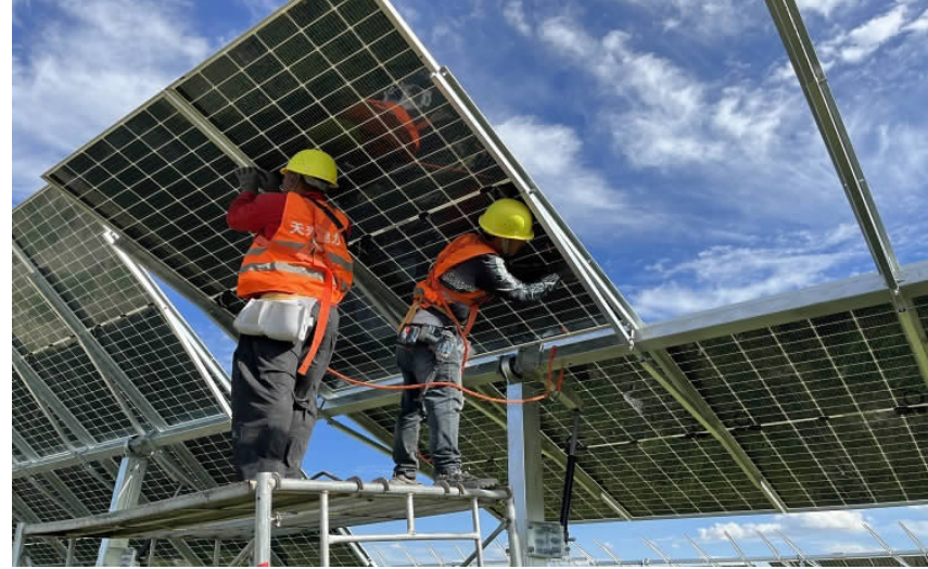
工人正在安装光伏板
