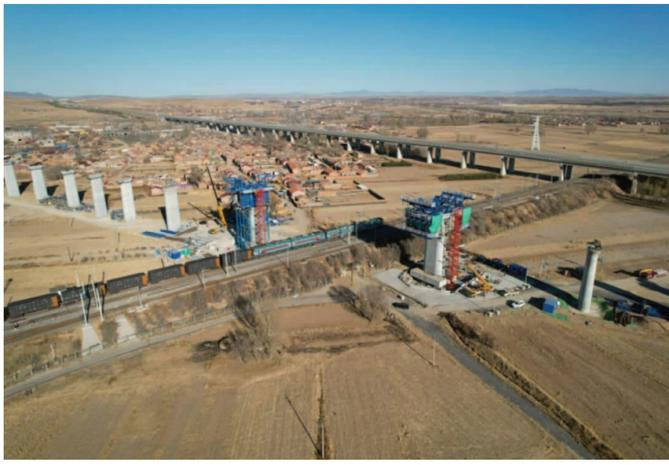
丰镇特大桥跨大准铁路(48+80+48)m转体连续梁施工
