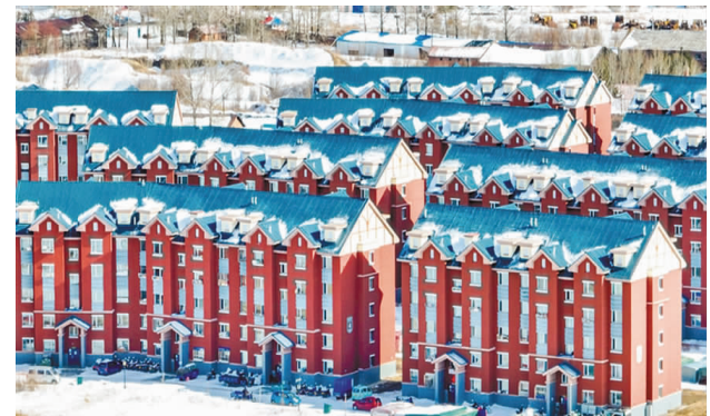
新建成的阿尔山市伊尔施街圣泉小区
