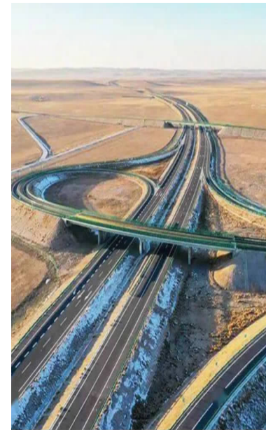
锡林郭勒盟重大项目开工现场
