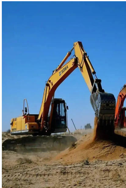
巴彦淖尔市重大项目开工现场
