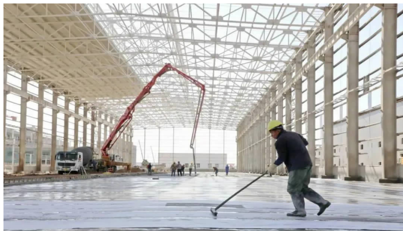
包头市重大项目开工现场
