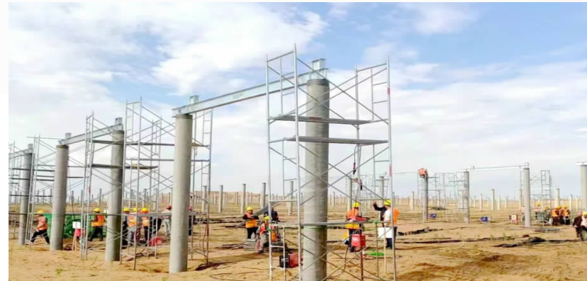
新能源基地施工现场
