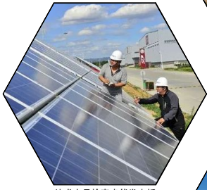
技术人员检查光伏发电板
