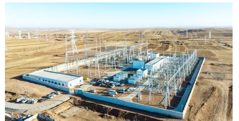
红泉 220 千伏输变电工程俯瞰图
