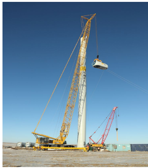
华润电力阿巴嘎旗500兆瓦风电项目风机吊装现场
