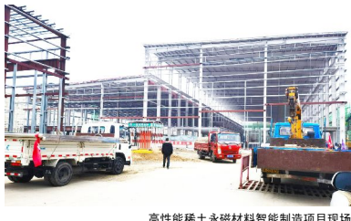
高性能稀土永磁材料智能制造项目现场
