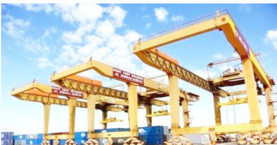
满洲里铁路口岸集装箱场
