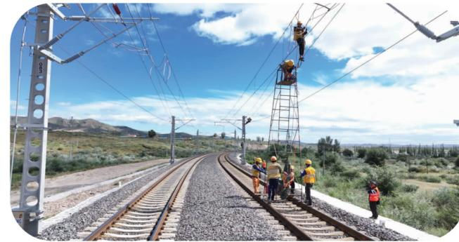
施工人员在集通铁路大哲段进行接触网导线调整作业 倪亚宁 摄
