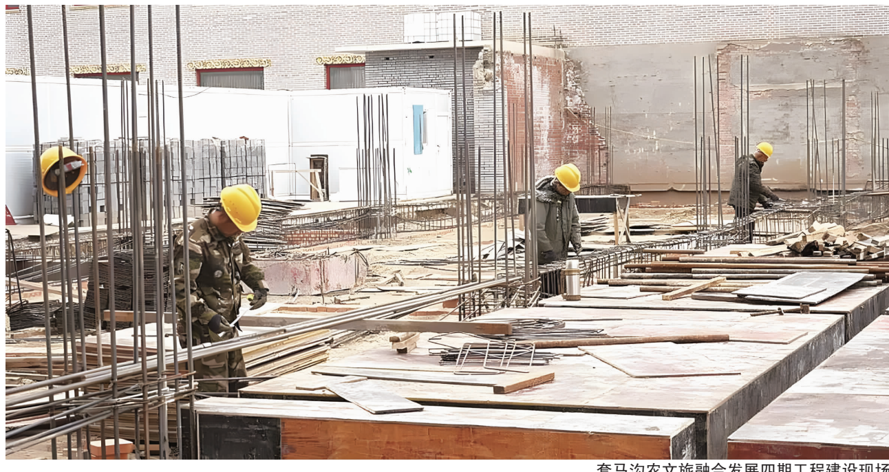
套马沟农文旅融合发展四期工程建设现场
