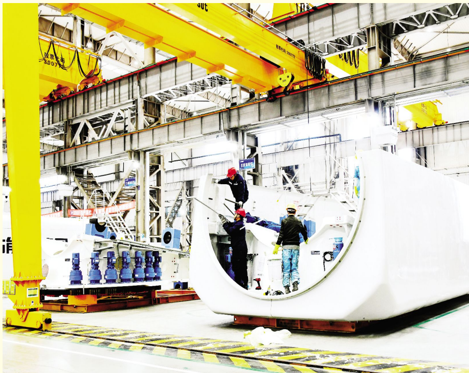
车间内工人正在安装风电机组
