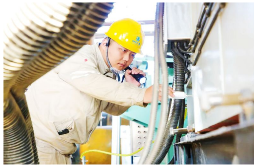
供热管网及设施检修
