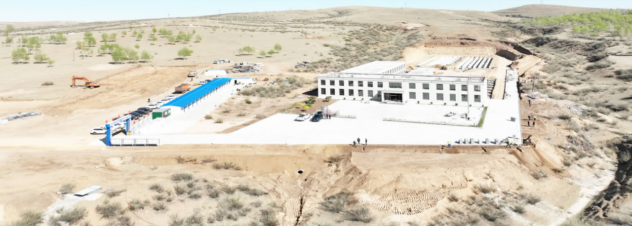
项目建设现场
