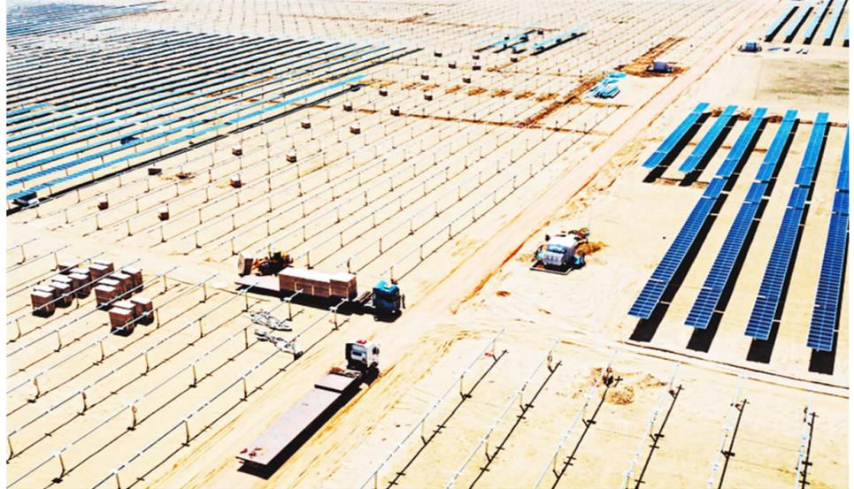
4月28日,鄂尔多斯市鄂托克前旗蒙西鄂尔多斯采煤沉陷区新能源4GW项目建设现场,工人正在安装太阳能光伏板和支架。该项目是列入国家第二批以沙漠、戈壁、荒漠地区为重点的大型风电光伏基地清单的新能源项目,总投资199.6亿元,项目全部并网发电后,预计年发电量75.77亿千瓦时,每年节约228.08万吨标准煤、减排二氧化碳627.15万吨。项目助推“蒙电东送”,对推动国家东西部资源互补,优化产业布局,缓解大气污染具有重大意义。(王晓博 摄)
