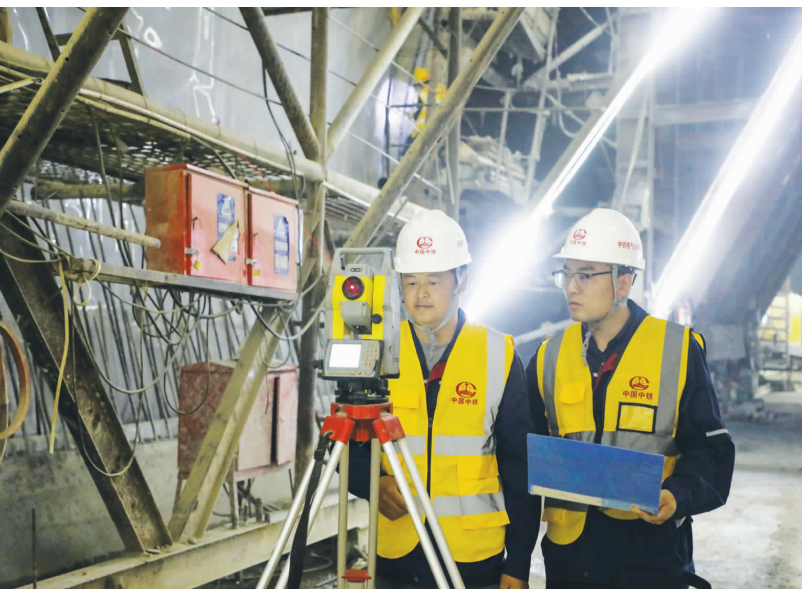
7月6日,经棚隧道内工作人员正在作业 孙江昆 摄
