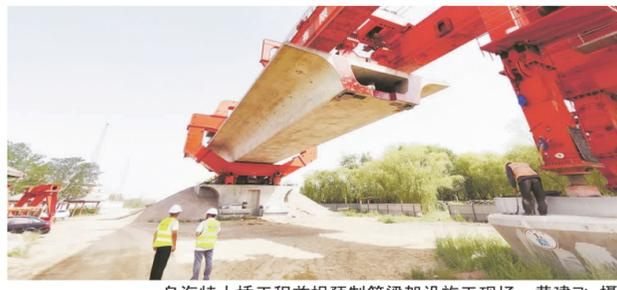
乌海特大桥工程首榀预制箱梁架设施工现场 黄建飞 摄
