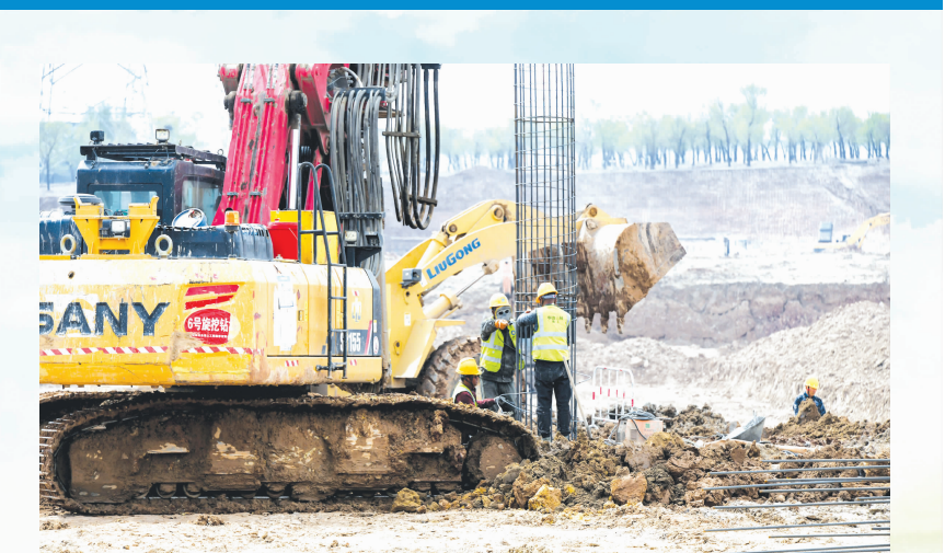
工人们正加紧作业
