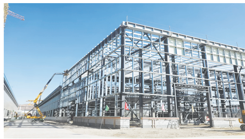
包头铝业有限公司相关项目正在施工
