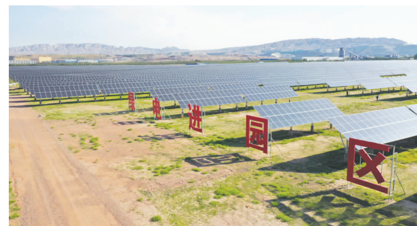
鄂托克旗绿电入园区项目
