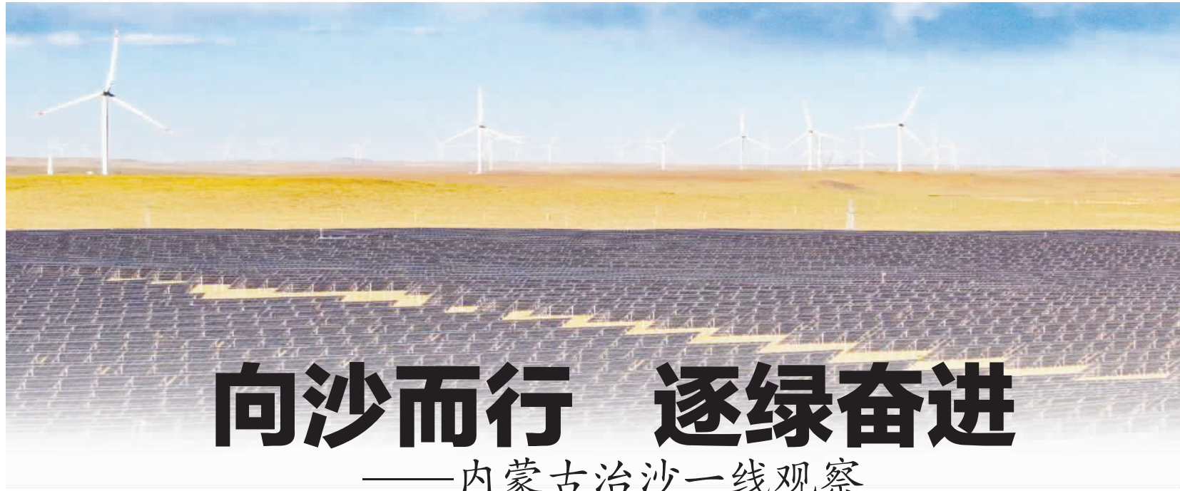
▲三峡新能源四子王旗有限公司风力光伏发电场
