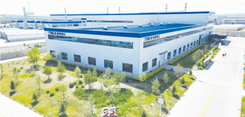
内蒙古特变电工能源装备有限公司厂区
