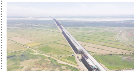
乌石高速巴音陶亥黄河特大桥项目建设现场
