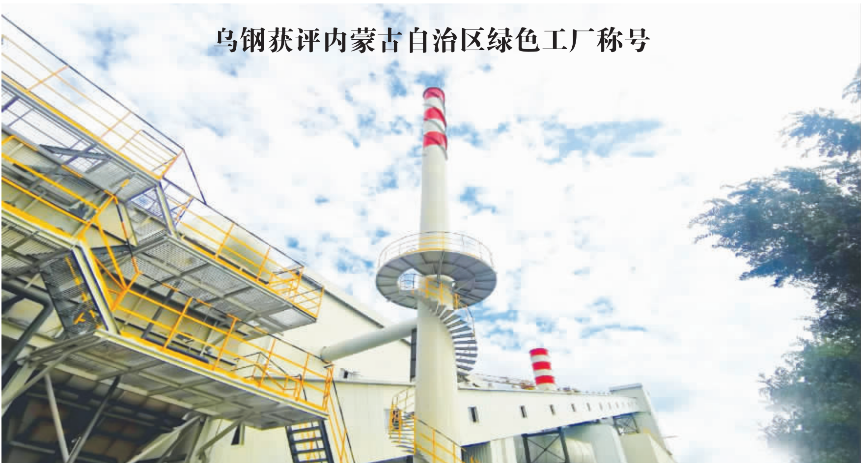
乌钢烧结厂的脱硫脱硝系统 郑志宏 摄
