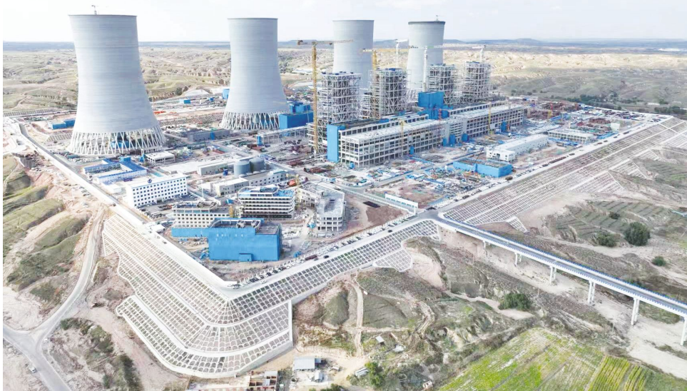
4座间冷塔全部封顶
